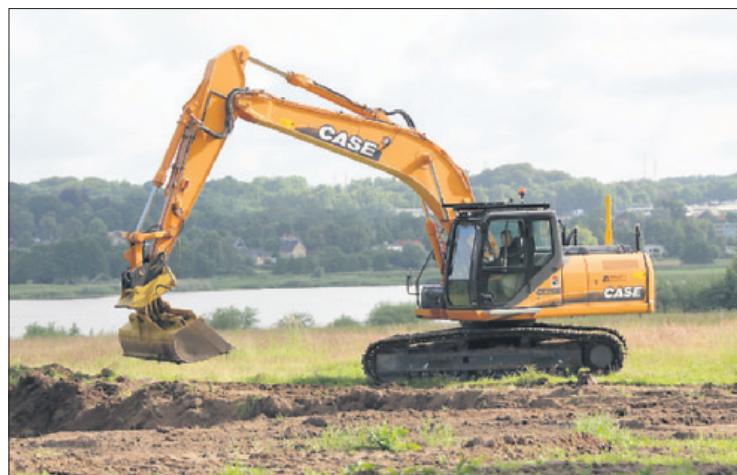
JM Tryklufths nye 21 tons gravemaskine i aktion med GPS-master på bagpartiet. I baggrunden ses Brabrand Søen.
